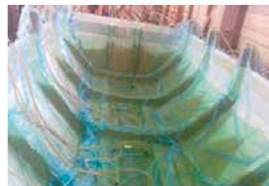
Процесс пропитки полноразмерной крыши вагона хоппера ООО «НТИЦ АПАТЭК-Дубна»
